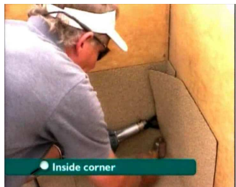
12. Las de verticale en horizontale overlap dicht.
