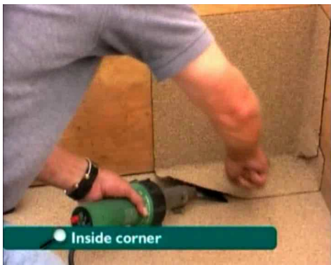
8. Las de overlap van de randstrook op het horizontale vlak.
