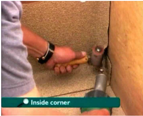
7. Las de vouw tegenaan de verticale opstand.
