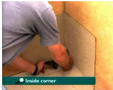
11. Snij een hoek af onder 45° waar de randstroken elkaar overlappen op het horizontale vlak.
